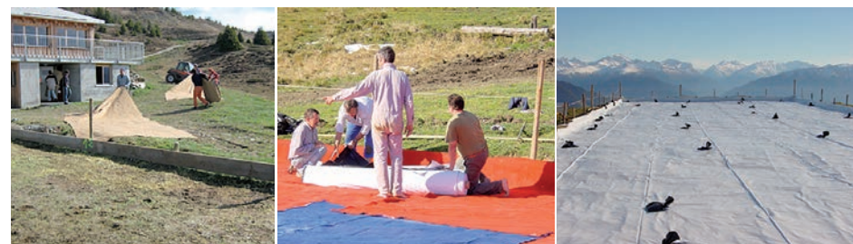
Die gesamte Fläche wird mit Teppich ausgelegt, damit die Folie keinen Schaden nimmt. Die Folie wird ausgelegt und mit wassergefüllten Abfallsäcken beschwert, damit der Wind sie nicht aufbläht und zerreisst. Das Wasser läuft 3-4 Tage ein...
